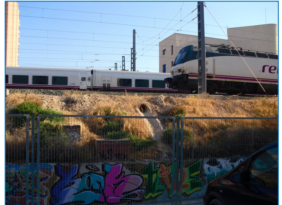
Foto nº32: Detalle desnivel entre playa vías de FFCC y encauzamiento de Barranco aguas debajo de las 4 hincas dn-1800 mm.
