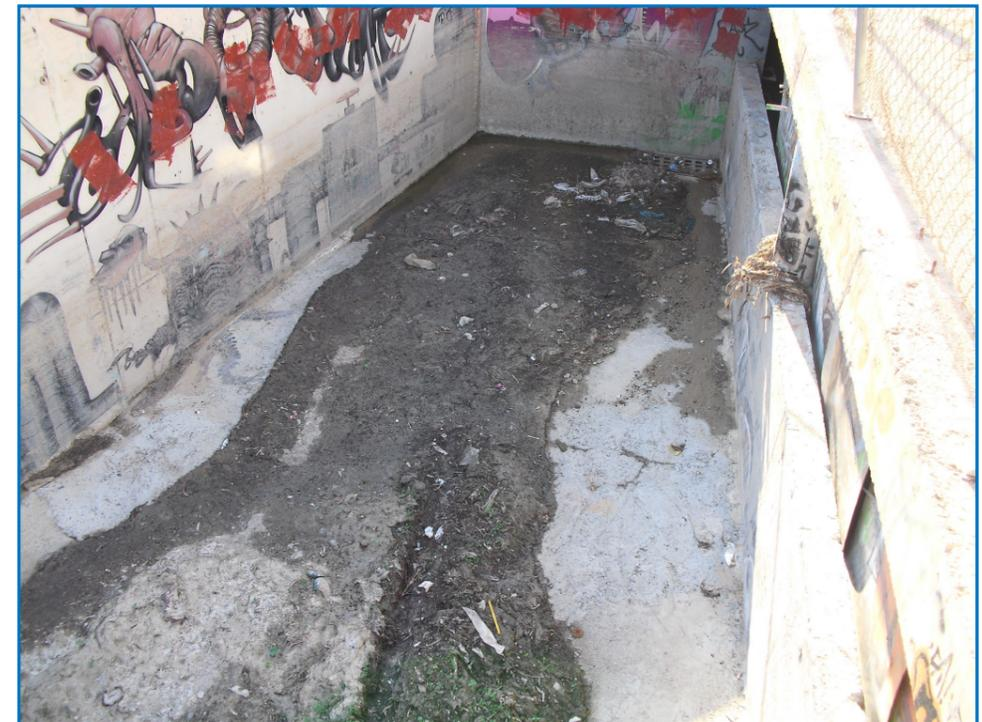
Foto n°28: Detalle de final de encauzamiento del barranco de San Blas. Arenero aguas arriba de la conexión con el colector de Oscar Esplá. Intersección calles Francisco Candela y Alcalde Ramón Hernández.
