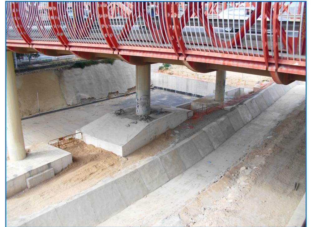
Foto nº7: Detalle del paso de la trinchera junto a las pilas del puente. Al fondo, losa del cajón del FFCC.
