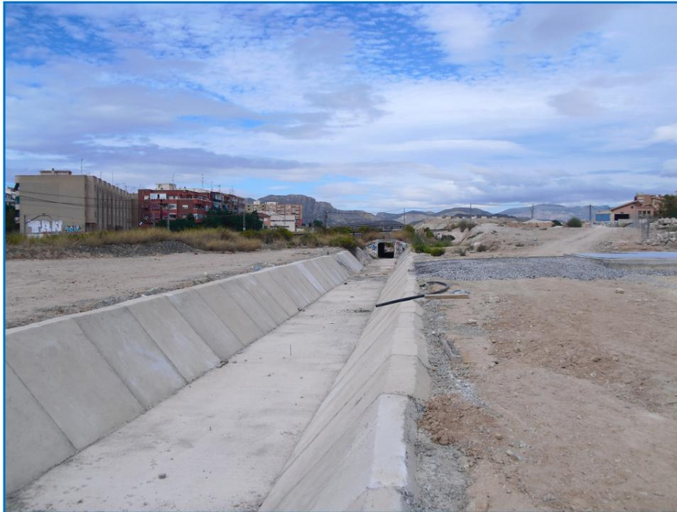
Foto n°1: Foto hacia aguas arriba. Encauzamiento del barranco de San Blas. Al fondo paso del FFCC.
