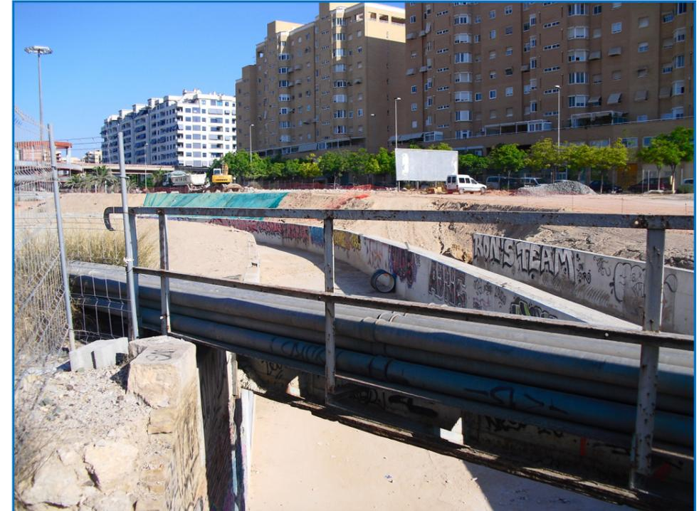
Foto n°11: Cruce del encauzamiento del barranco bajo las vías del FFCC.
