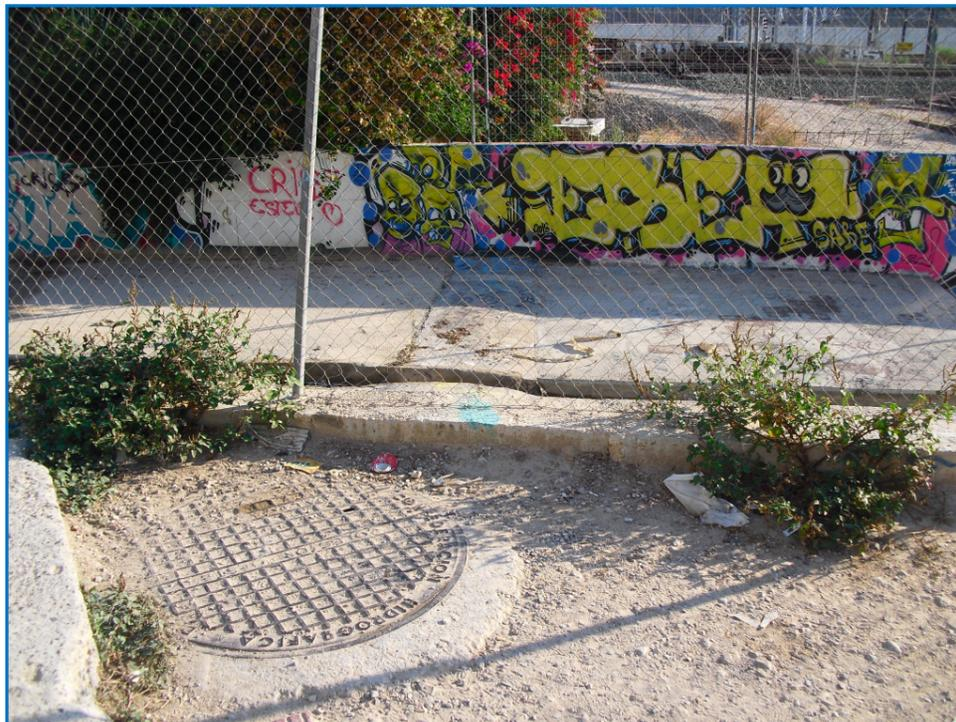
Foto nº18: Detalle de tapa de registro del colector oeste en su punto de cruce con el encauzamiento del barranco de San Blas.
